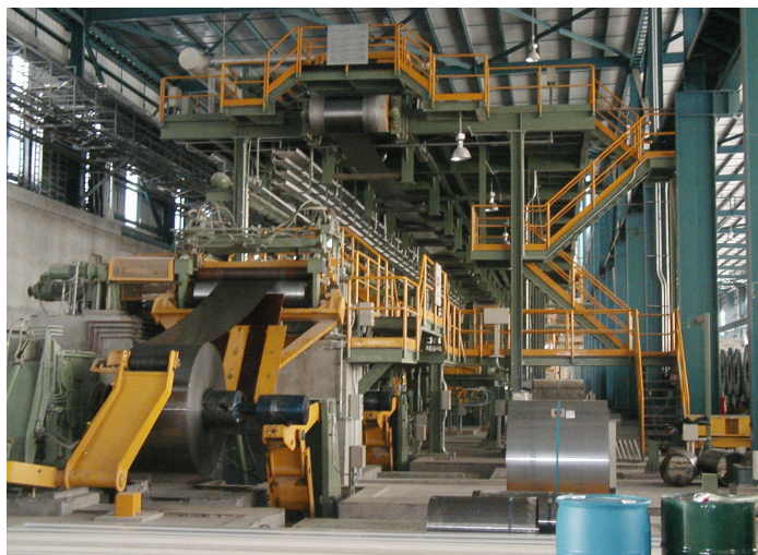
Vista de la planta en la cual se realizó la aplicación.
